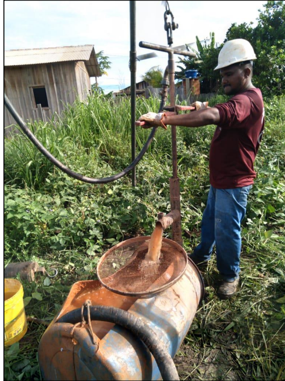
EXECUÇÃO DA SONDAGEM A PERCUSSÃO – SPT-01
