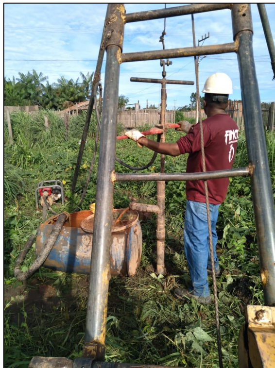
EXECUÇÃO DA SONDAGEM A PERCUSSÃO – SPT-02
