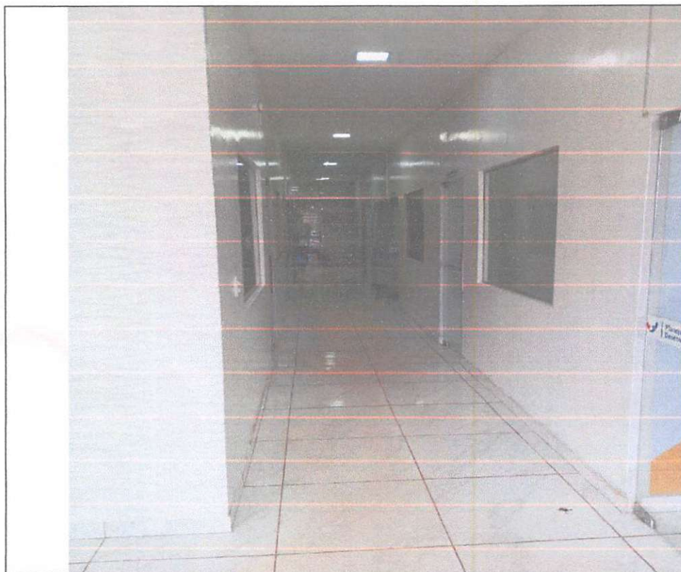
CORREDOR DE ACESSO AS SALAS RECEITA FEDERAL, IDENTIFICAÇÃO, TECNICOS, SINE, GABINETE, REUNIÃO, DEFESA CIVIL, ARQUIVO, COPA E BANHEIROS
