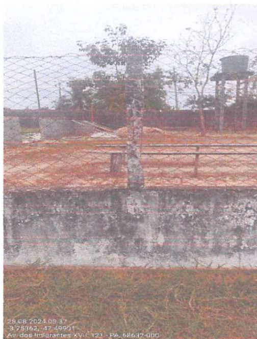
Figura 6 – poste de concreto que sustenta a tela alamedado danificado. Fonte: Autor, 2024
