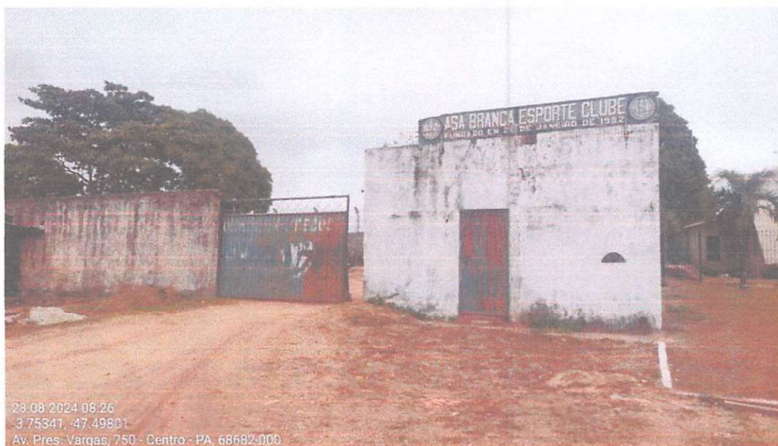
Figura 2 – Fachada do Estádio Asa Branca Esporte Clube – Apresenta fissuras. Fonte: Autor, 2024
