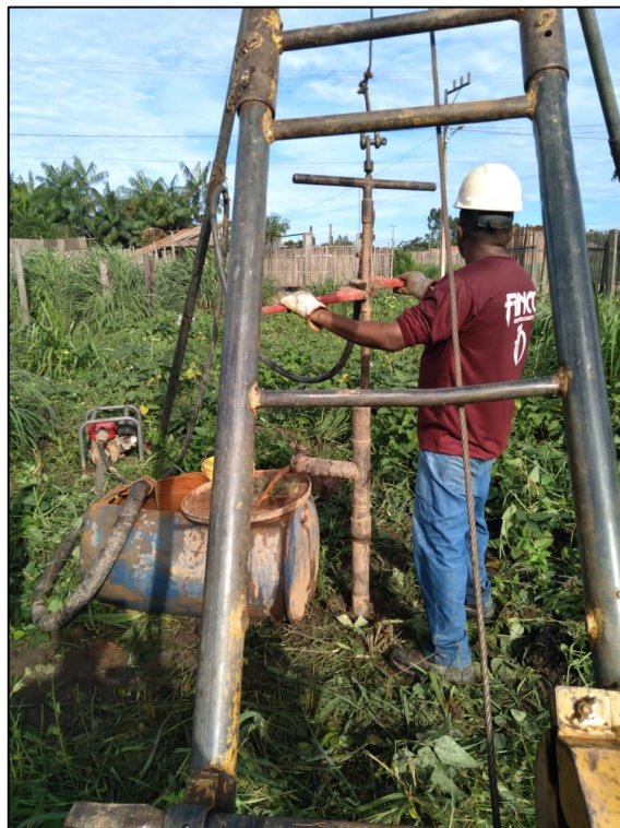
EXECUÇÃO DA SONDAGEM A PERCUSSÃO – SPT-02
