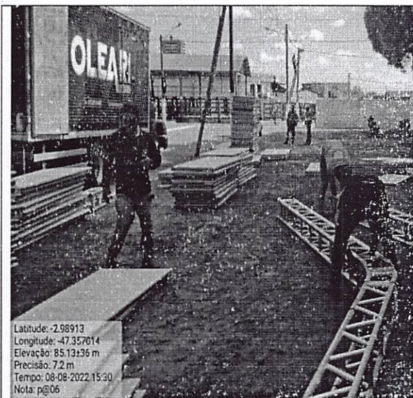
Foto 03- instalação das tendas em estrutura metálica e lona plástica e piso em compensado em madeira.
