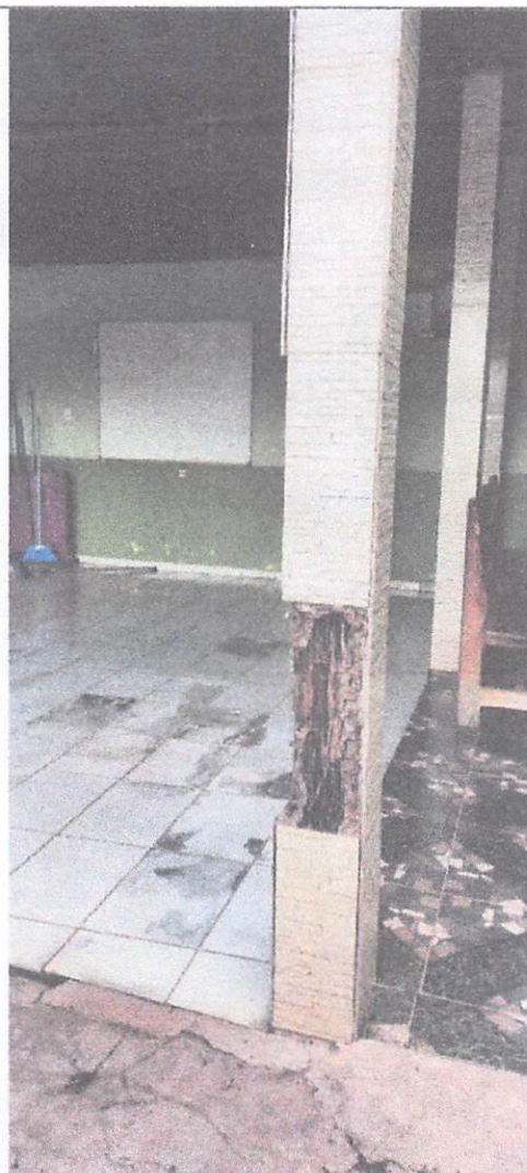
Pilares do refeitório
