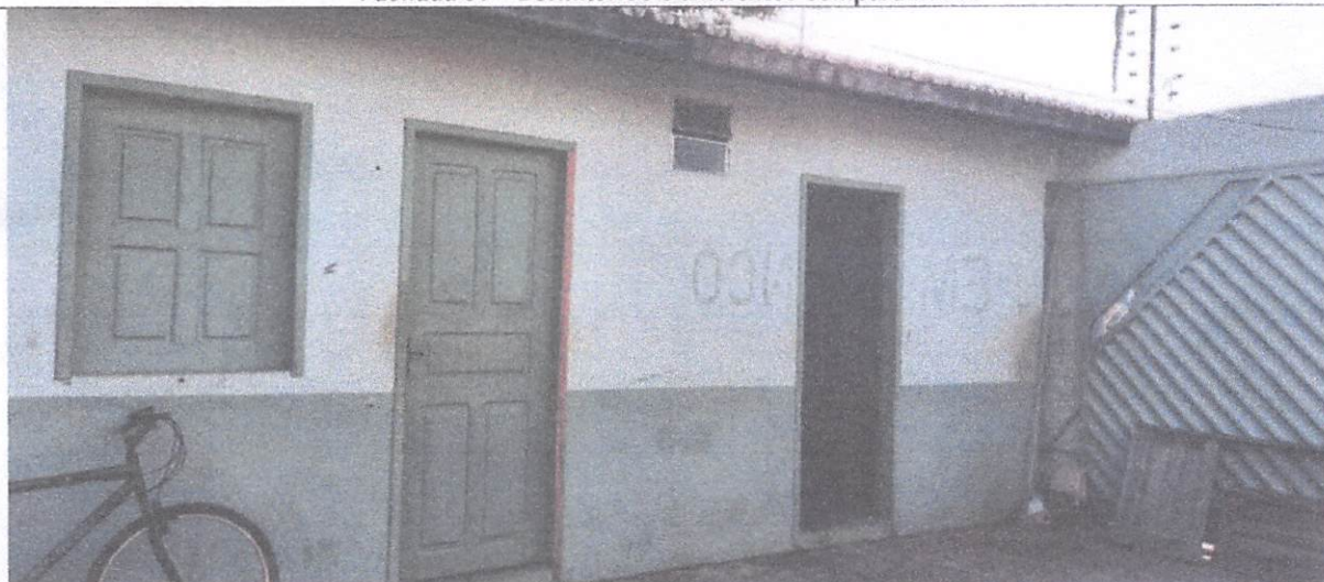
Fachada 02 – Administrativo e despensa
