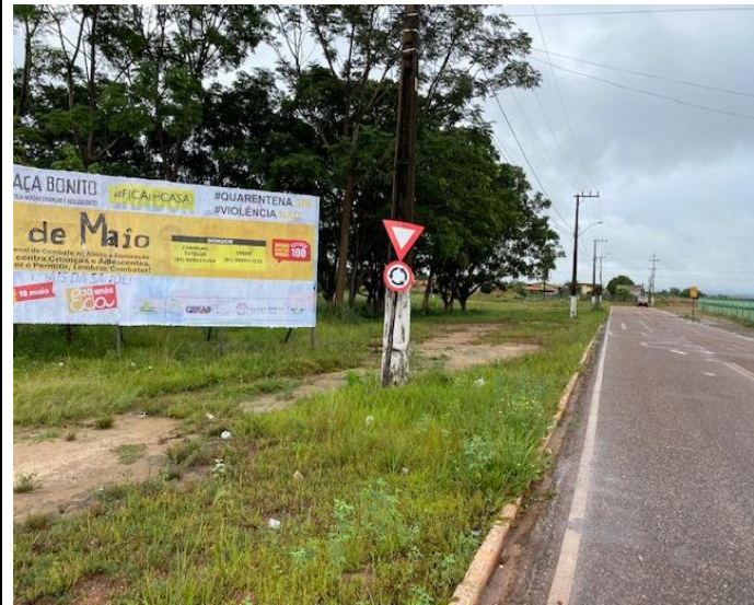
2 – Rua Paraíba (lateral Pista de Corrida)
