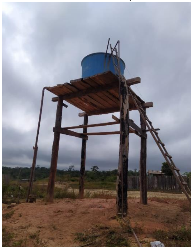
Figura 4: Reservatório existente com capacidade de 10 m 3 .
